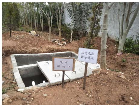
生产废水沉淀池（接园区污水管网）
